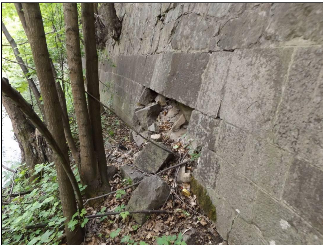
Obr. č. 5 – pohled na vyvalené kvádry vápence ve spodní části opěrné zdi
